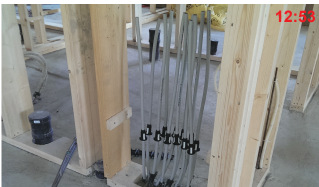
2 Skapgjennomføringer plasseres litt i underkant av treklossene skapet skal hvile på.
