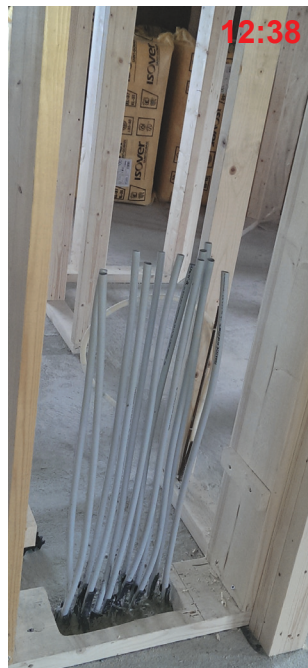
1 Rørene kuttes slik at de stikker godt over øverste fordeler i boligsentralen.
