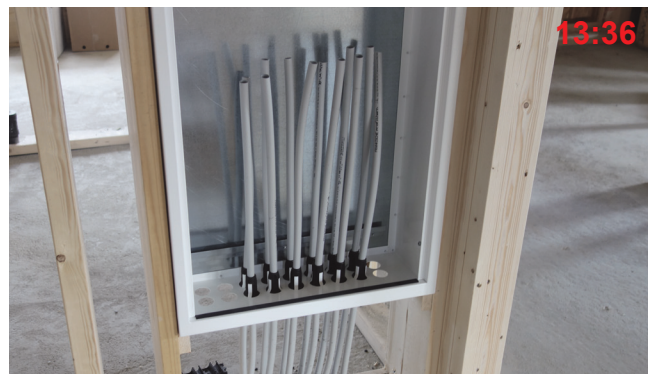
4 Skapgjennomføringer dyttes opp til de låses.
