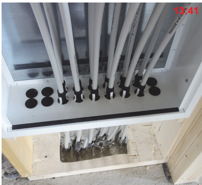
5 Hullene som ikke er i bruk plugges ovenfra.
