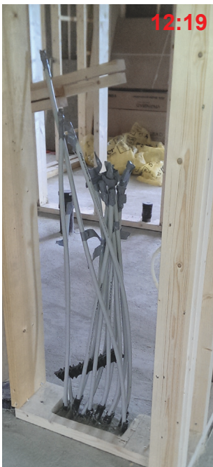
1 Rørene kuttes slik at de stikker godt over øverste fordeler i boligsentralen.
