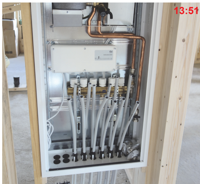
7 Rør på returfordeler kobles til.
