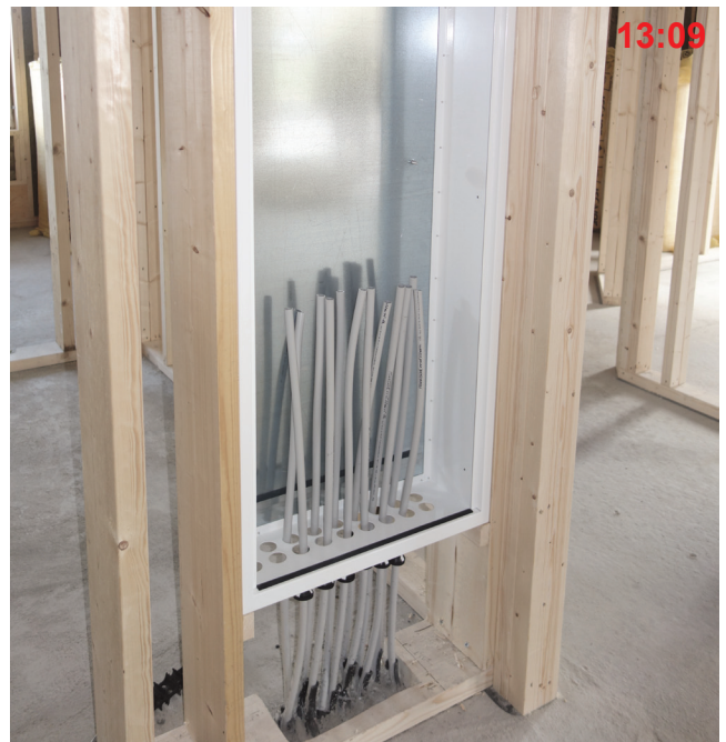
3 Bakplaten med boligsentralen tas ut av skapet og man trer skapet ned over rørene til det hviler på treklossene.
